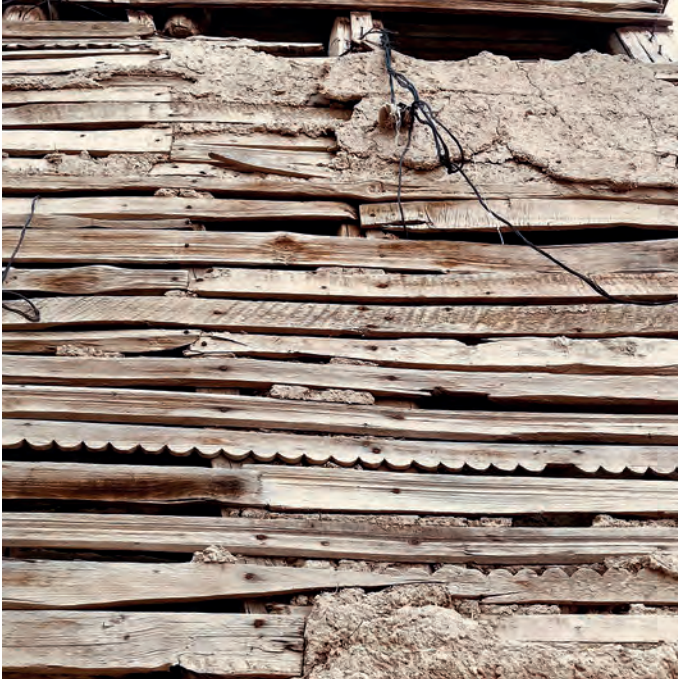
Kerpiç Yapıda Ahşabın Bağdadi Çıta, Döşeme ve Dikme Olarak Kullanımı / Atabey – Kuleönü
