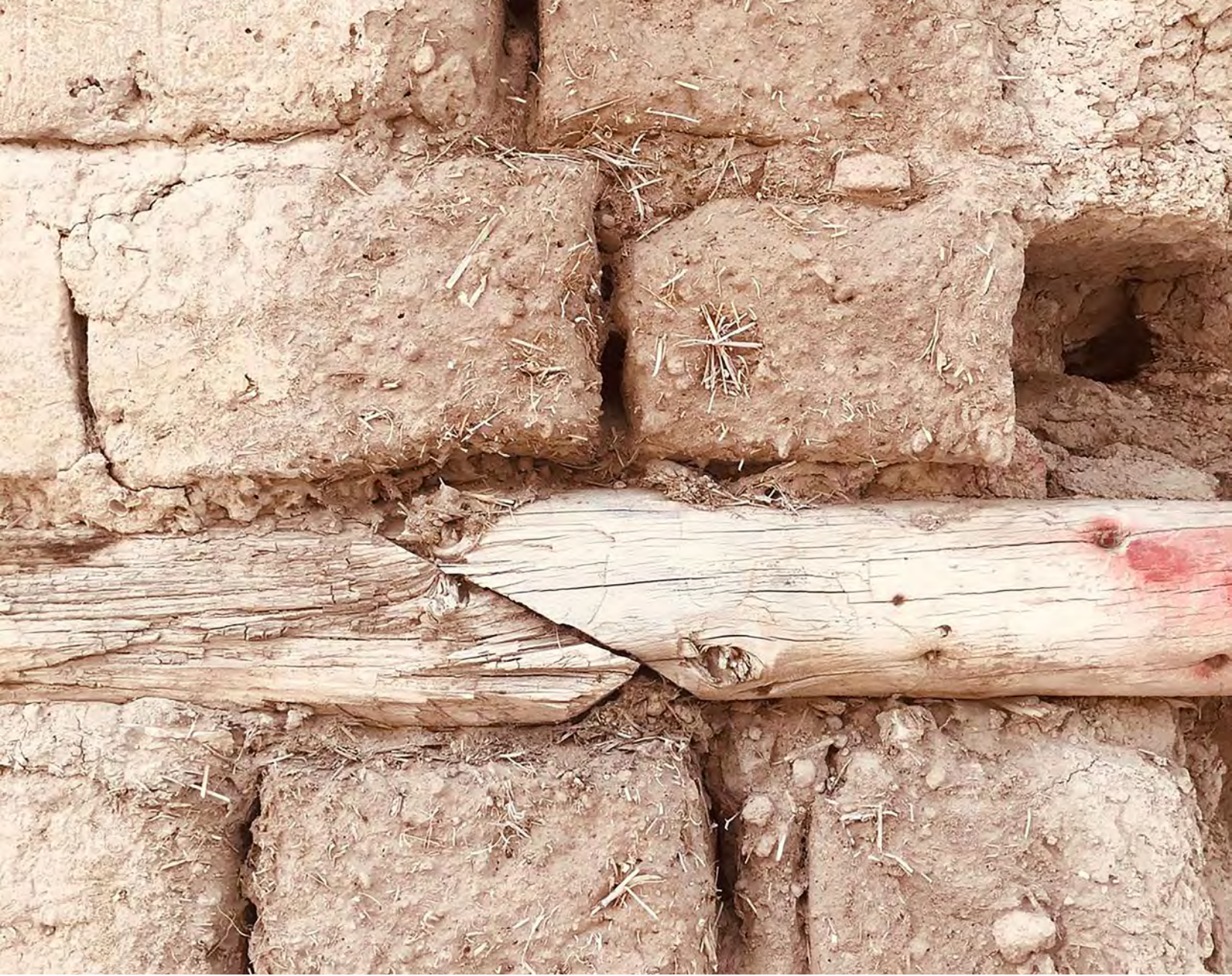
Hatıllarda Ahşap Birleşim Detayı
