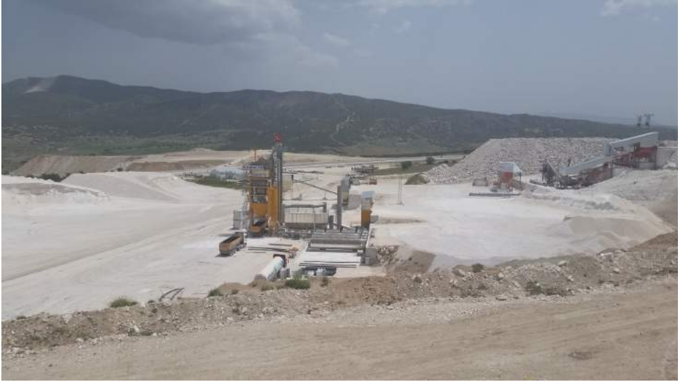
Şekil 12.2. Doğal taş ocak artıklarından yol malzemesi ve asfalt agregası üretimi
