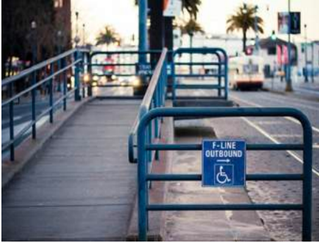
Şekil 2.7. Tekerlekli sandalye kullanıcıları için hafif raylı sisteme geçiş rampası (Photo: Rafael Castillo/Flickr, 2015)
