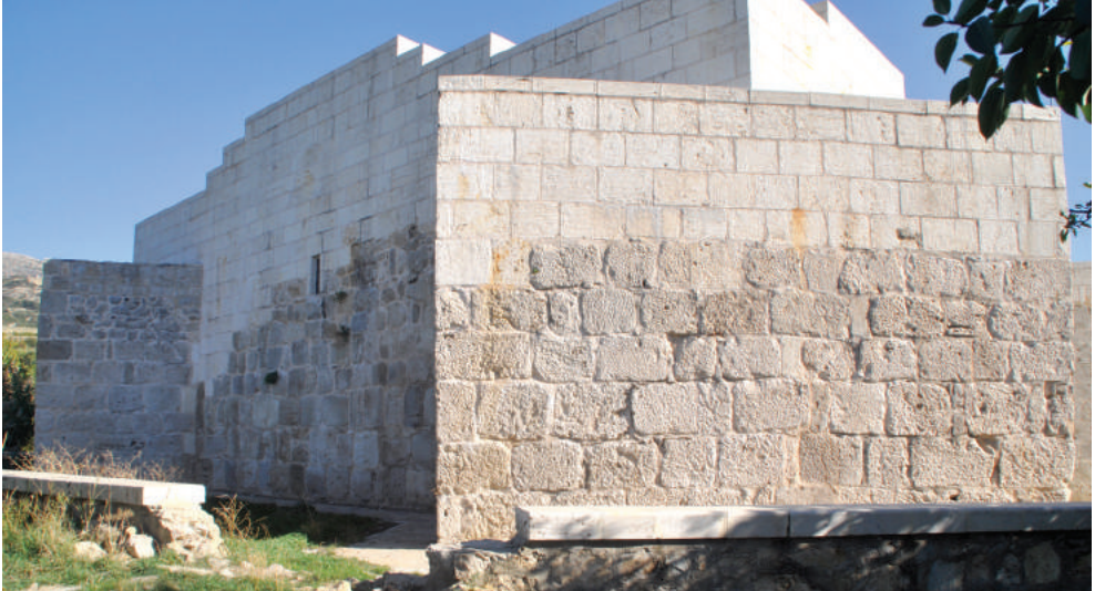
Resim-55 Ertokuş Kervansarayi'nin arka cephesinden genel görünüşü (Restorasyon sonrası)
