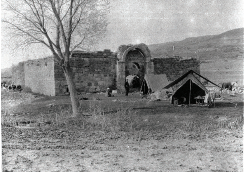
Resim-15 Kervansarayın 1907 yılında çekilmiş fotoğrafı (Gertrude Bell'den)
