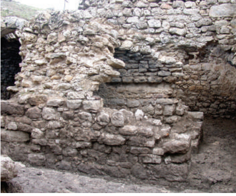
Resim-21 Duvardaki ahşap kalas yuvası
