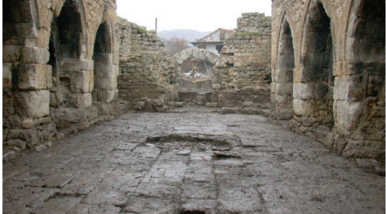
Resim-43 Açık avlunun taş döşemesi
