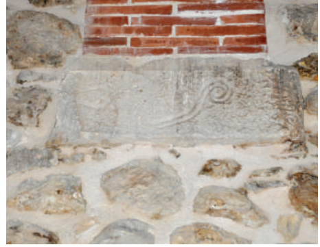
Resim-51 Kapalı kısım, batı tonoz kemerini destekleyen devşirme konsol parçası
