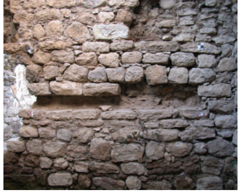
Resim-22 Duvardaki ahşap kalas yuvası
