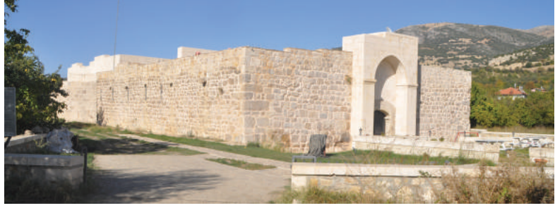
Resim-17 Kervansarayın restorasyon sonrası görünümü
