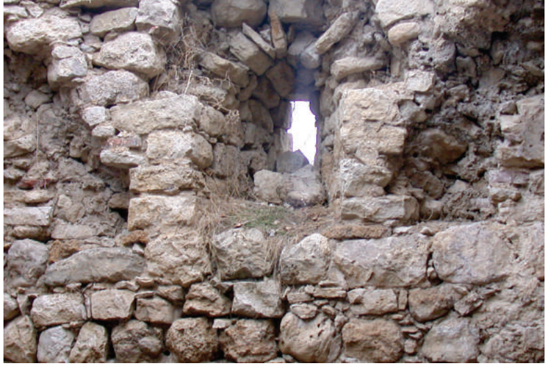
Resim-27 Kubbeli mekanda köşe trompları ve sökülen tuğlalar
