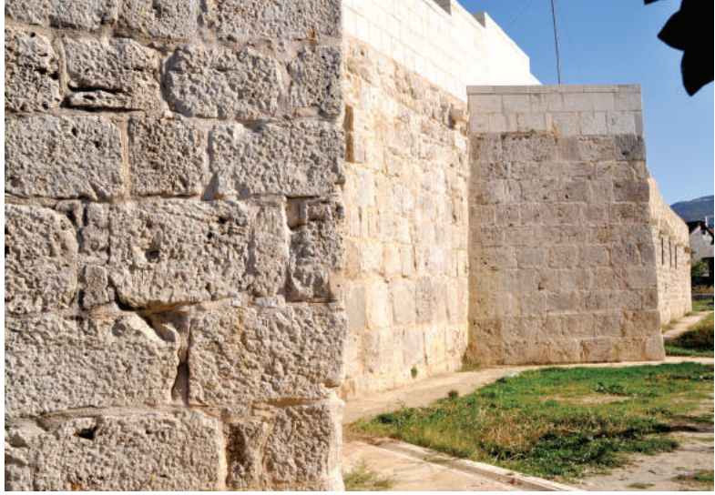
Resim-54 Ertokuş Kervansarayı'nın batı cephesinden genel görünüşü (Restorasyon sonrası)
