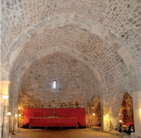
Resim-34 Kapalı kısım orta tonoz (Restorasyon sonrası)
