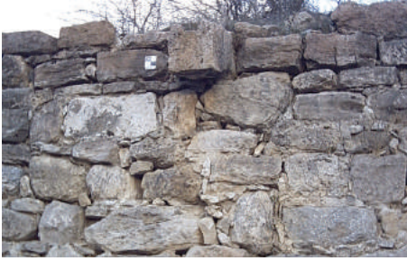
Resim-49 Doğu duvarında çörten
