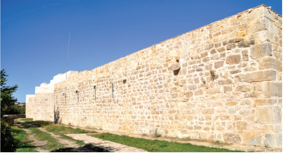
Resim-53 Ertokuş Kervansarayı'nın batı cephesinden genel görünüşü (Restorasyon sonrası)
