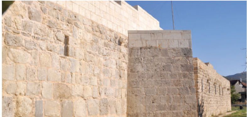
Resim-18 Kervansarayın batı cephe duvarı ve üçgen payandası
