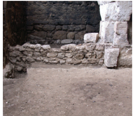
Resim-46 Kervansarayda moloz ve düzgün kesme taş kullanımı
